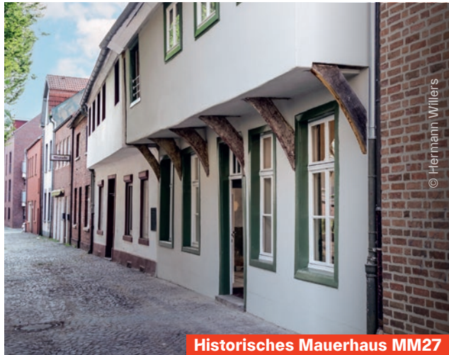
Historisches Mauerhaus MM27
